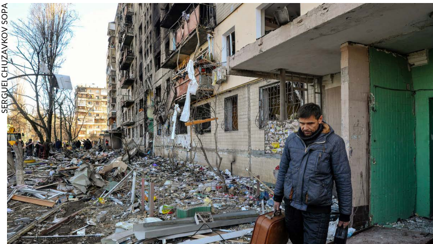
Immeuble d'habitation bombardé à Kiev.
