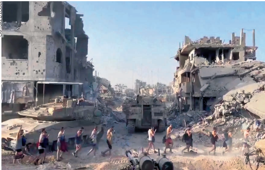
Après la destruction de l'hôpital Kamal-Adwan.
