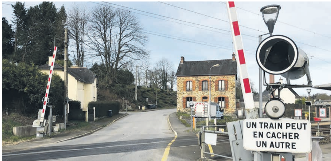
Le passage à niveau de Saint-Médard sera supprimé... en 2020.
