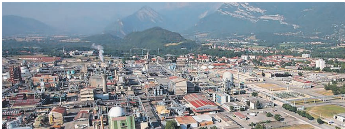
La plateforme chimique de Pont-de-Claix.
